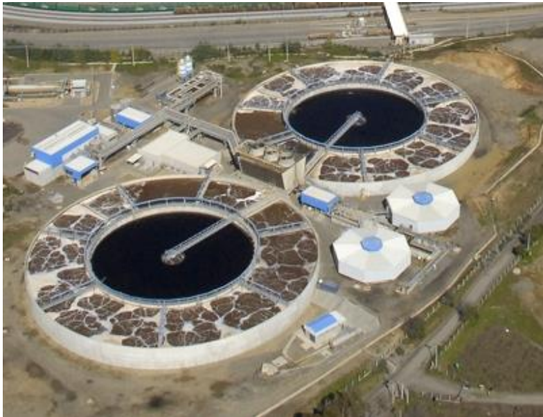
Nueva Aldea effluent treatment plant, Chile
